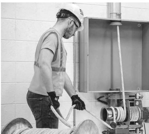
**Figure 32 : Position d'utilisation adéquate de la fixation à chaîne**
